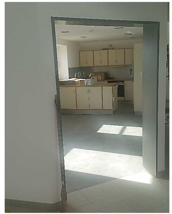
Aus dem gelben Zimmer, dem Waschraum und dem Lagerraum entsteht nun die Küche und der Speiseraum für die zukünftigen kleinen Besucher
