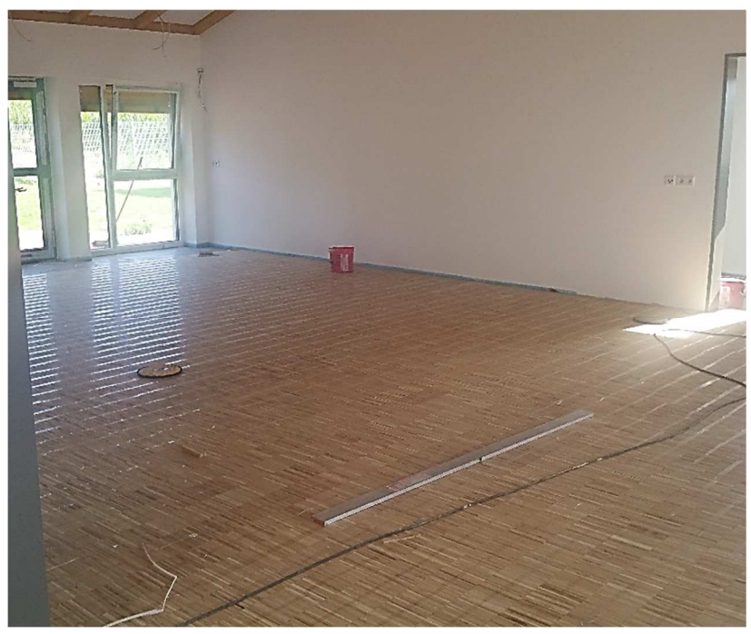
Der neue Gymnastikraum für die KiTa Biburg
