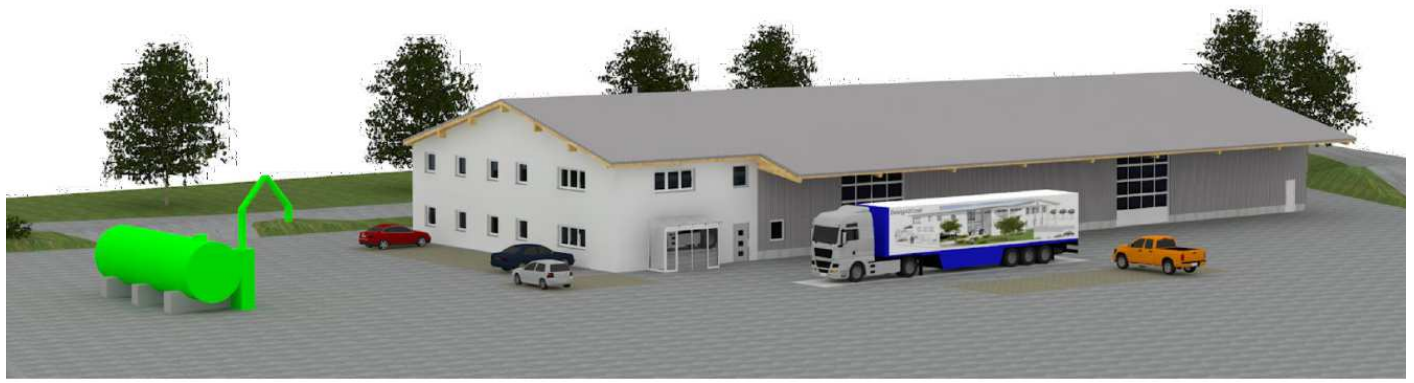
Das ist der Blick auf das Bürogebäude, das PSM-Lager und das Stückgutlager von der Düngerhalle aus. Hinter diesem Gebäude befindet sich die GVS Dürnhart – B301
