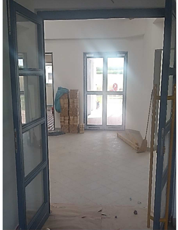
Die Kinderkrippe entsteht aus dem alten Kindergarten
